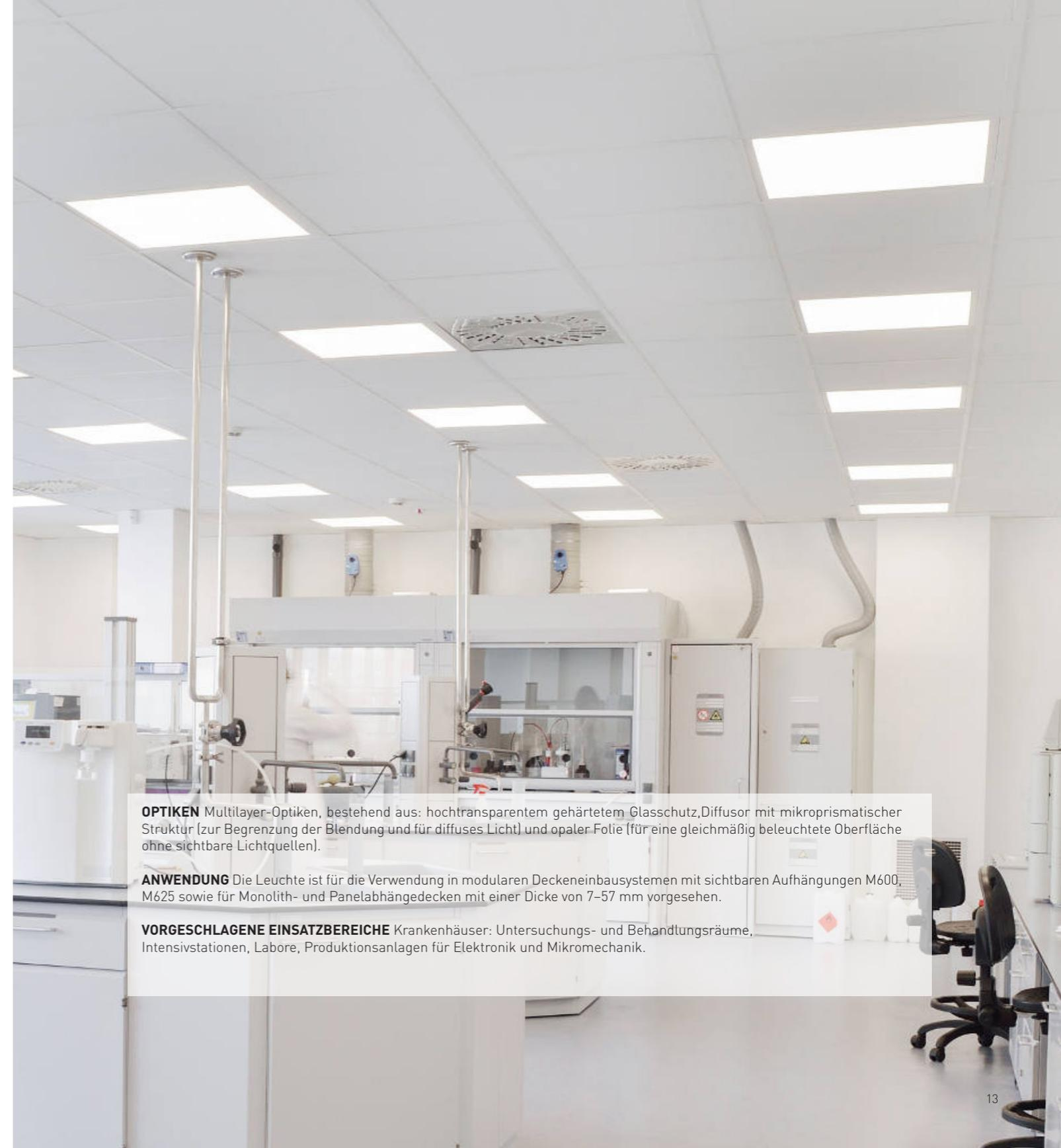
**OPTIKEN** Multilayer-Optiken, bestehend aus: hochtransparentem gehärtetem Glasschutz, Diffusor mit mikroprismatischer Struktur (zur Begrenzung der Blendung und für diffuses Licht) und opaler Folie (für eine gleichmäßig beleuchtete Oberfläche ohne sichtbare Lichtquellen).
