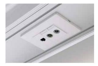
KOMMUNIKATION Es können Standard-Kommunikationskomponenten installiert werden, wie Telefonsteckdosen, LAN / INTERNET, Radio, SAT-TV, sowie Überwachungs- und Datenübertragungssysteme, die die Lebensfunktionen des Patienten registrieren. Verschiedene Arten und Klassen von Signalkabeln werden für die Verbindung benötigt. Die Kommunikationseinheiten sind in einem separaten Kanal installiert und für das Niederspannungsnetz vorgesehen und entsprechen den relevanten Spezifikationen.
